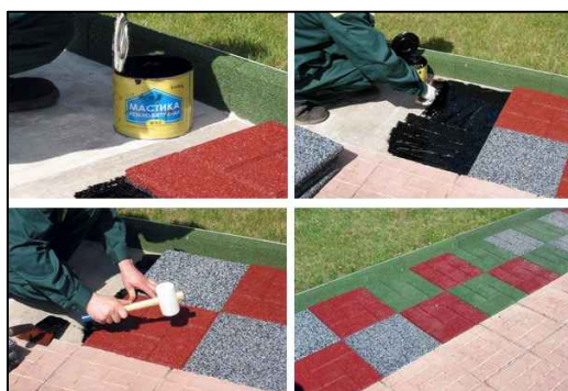
Устройство пирога под покрытие из резиновой плитки
